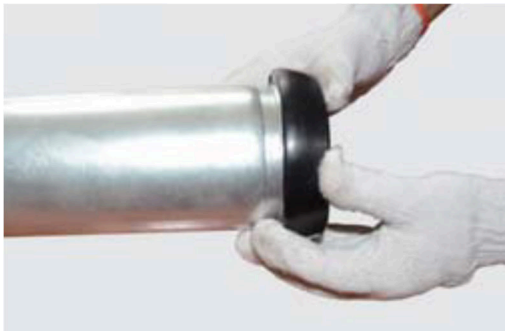
Inserimento della guarnizione
